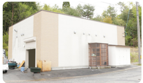
※東広島ジビエセンター外観
